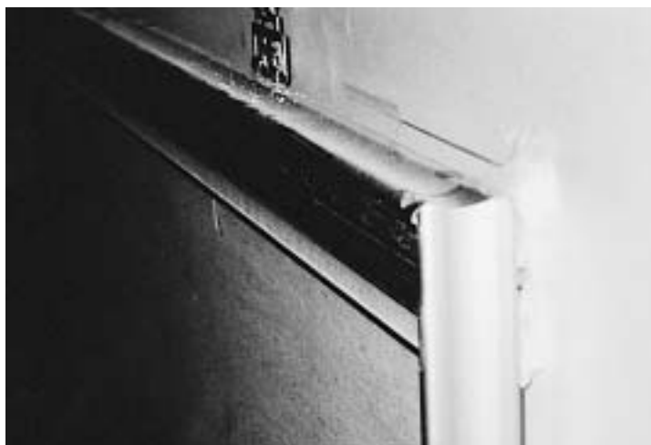
圖九 用微晶蠟將油畫畫框固定在牆上，亦可有效保護畫框免於震害
