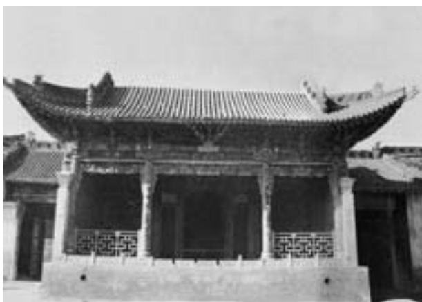
圖二六 明代改革性戲臺—埋置音缸及青石鏤空音穴擴聲 (山西翼城縣樊店村關帝廟戲臺)
