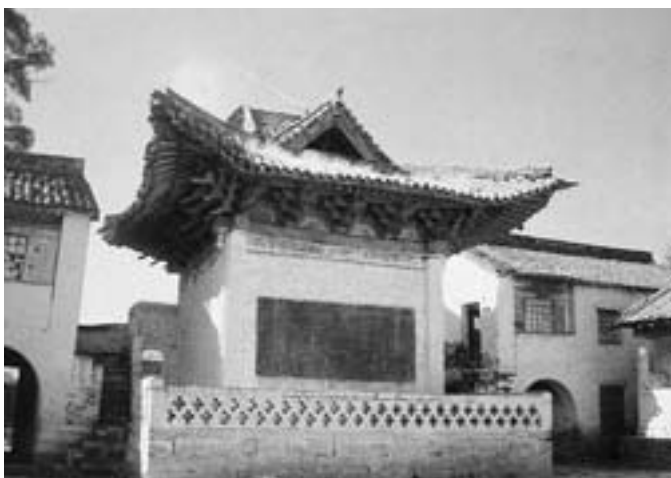
圖一三 山西晉城縣冶底村東嶽天齊廟金代戲臺
