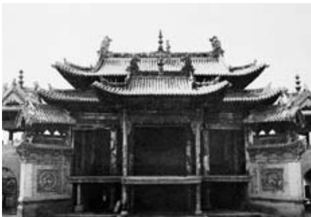
圖二五 明代改革性戲臺—八字形影壁攏音 (山西介休縣城內后土廟戲臺)
