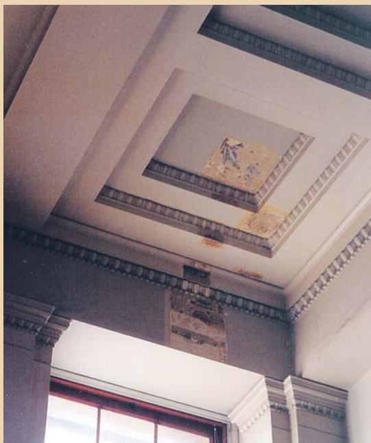
圖三 修復前，大英博物館入口門廳舊有牆面為灰色水泥漆；圖中，天花板與邊牆的數塊有彩方格，為正在進行原有彩繪層調查的「檢視窗」。圖由王竹平提供，攝於2000年。
