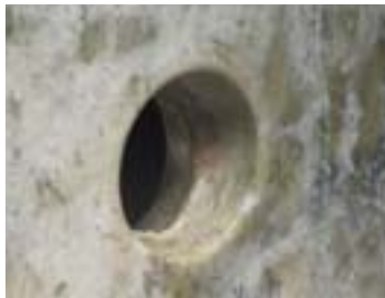
圖三七b 孔壁中央有一圈「接合線」
