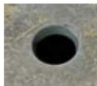
圖三九b 一面孔徑 1.75公分，孔邊留著 當初鑄錯位的痕迹
