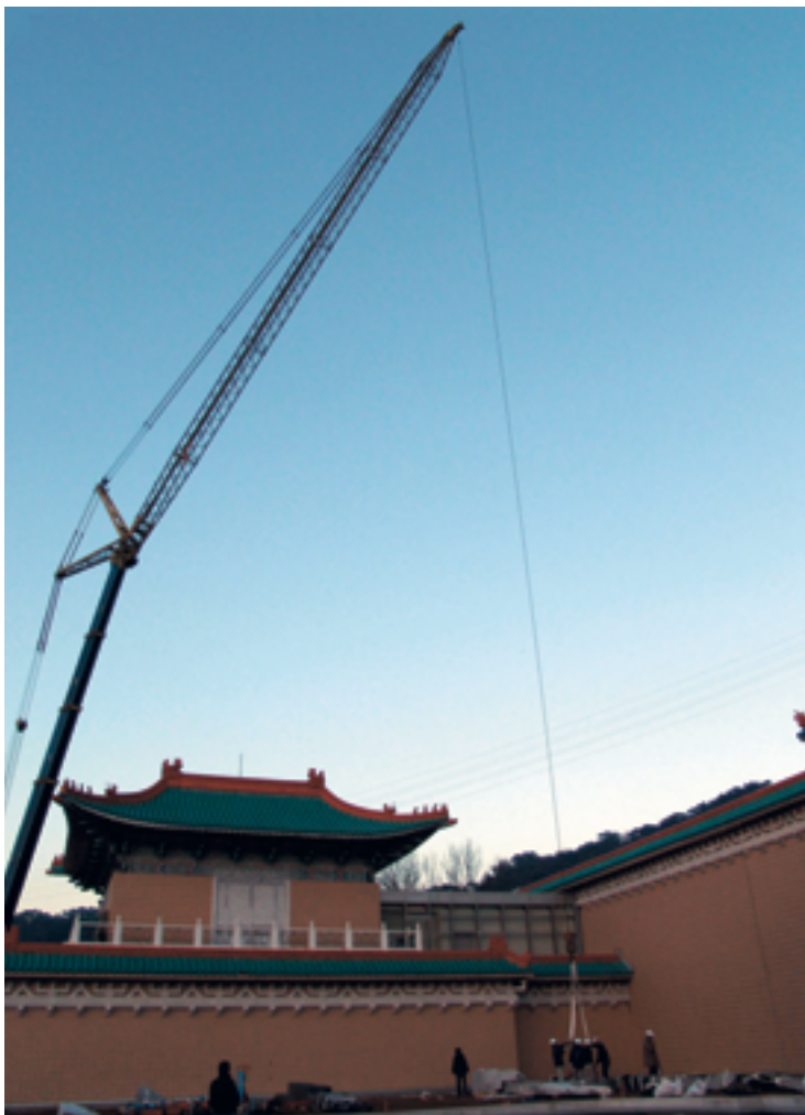
吊裝機具越過屋簷將石材送上二樓花台 林亦蘭攝
