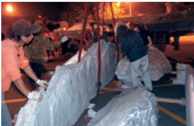
工作人員抵著寒風細雨，小心翼翼地進行吊裝石材前的最後確認。林亦蘭攝
