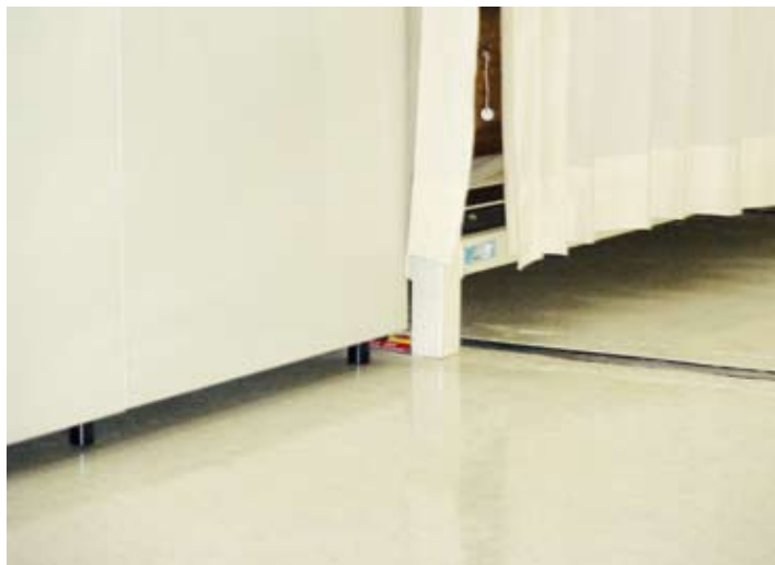
圖五 蒐藏架比地面高出四到六英吋，可防止水災直接波及，以及減少蟲害的發生。
