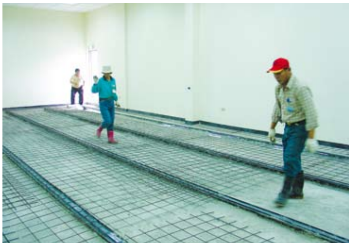
圖三 水泥鋪設之前先加設鐵絲網
