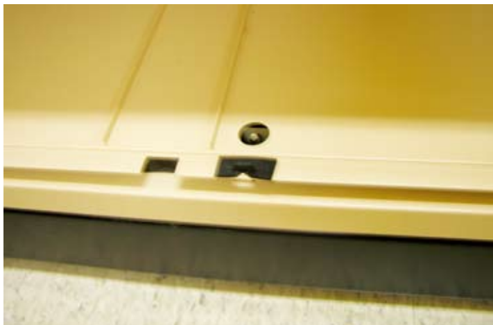
圖四 櫃子裡面裝設調整水平的裝置
