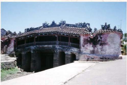
圖四 來遠橋（通稱「日本橋」）
