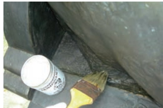
圖十一 以筆刷或漆刷沾無酸臘封護
