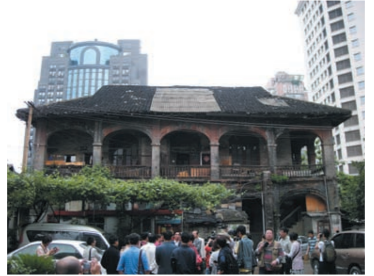
圖十四 貴陽毛光翔公館主樓
