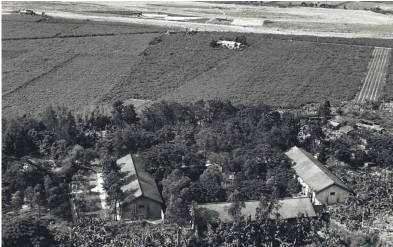
圖十 霧峰北溝故宮庫房鳥瞰。(莊靈攝 1950s) 1999年九二一大地震後，這裡已經變成被瓦礫和灌木叢蟻踰的一片廢墟。
