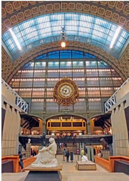
圖3 奧塞美術館的內部空間以大跨距的鑄鐵結構與玻璃構成，底層的中央雕塑長廊貫穿整個車站的完整空間。 作者攝
