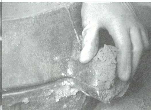
圖版一一 塞緊海浦軟泥於注入口。
