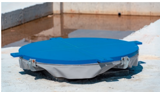
圖 29 摩擦單擺支承隔震器 攝於 2024 年 9 月 24 日 南院處提供
