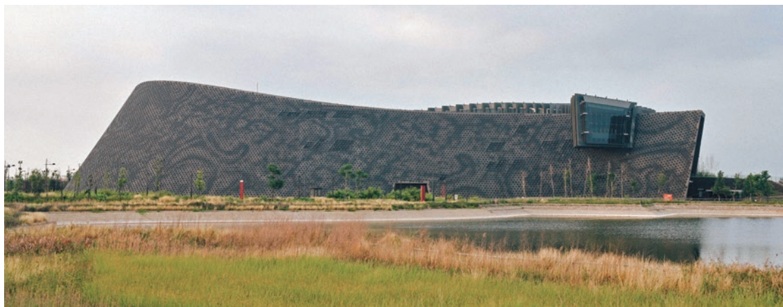
圖 6 一館建築外牆密布著 36,000 多枚、5 種不同尺寸的鑄鋁圓盤。 攝於 2018 年 5 月 14 日 南院處提供
