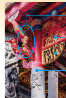
插拱 類似樑的結構 托木 柱子
